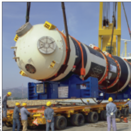
Transport d'un générateur de vapeur.
