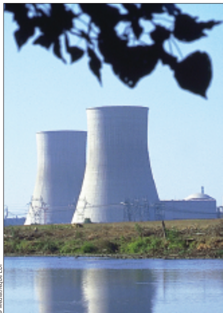
La centrale nucléaire de Civaux (Vienne).
